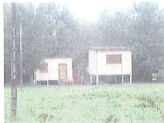
Constructions "sauvages" en zone inondable.
